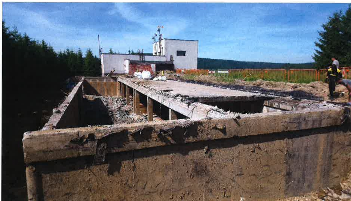
Rekonstrukce VDJ 3000 Teplice nad Metují.
