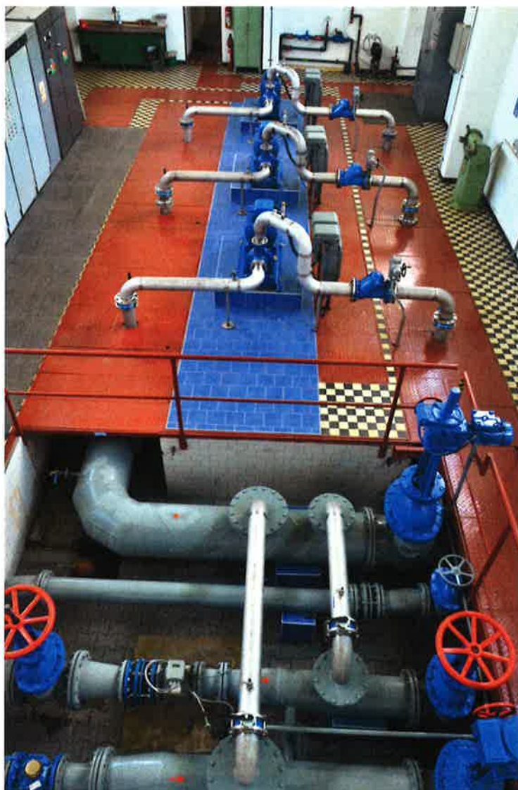
Cerpací stanice Vysoká Srbská.
