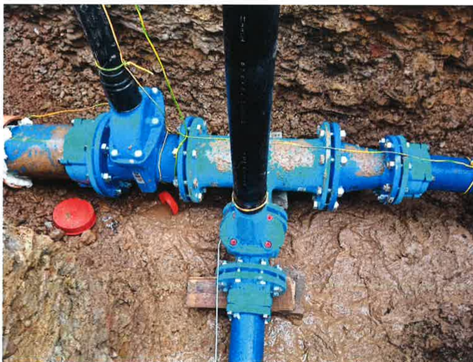
Výstavba vodovodu – Velké Poříčí
