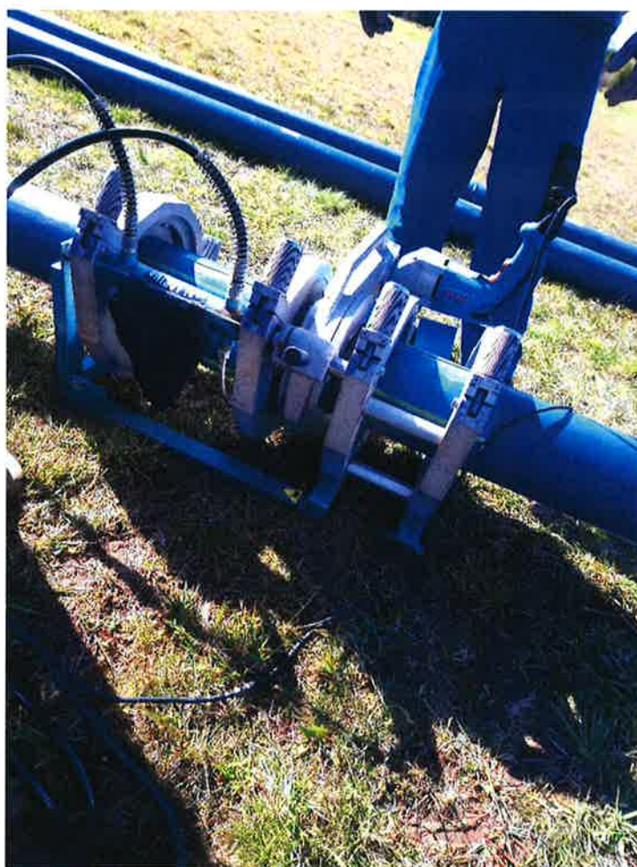
Rekonstrukce vodovodu D 250 - Jetřichov.
