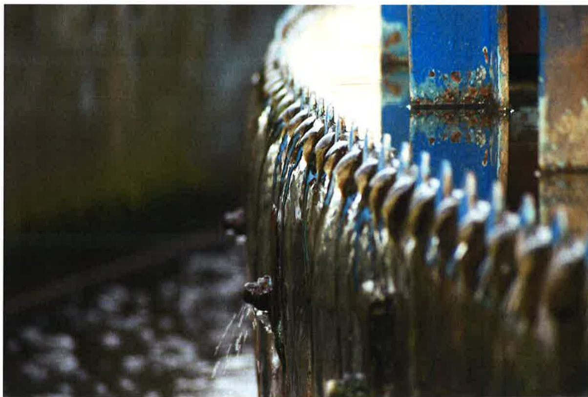
Odtok vyčištěné vody z dosazovacích nádrží ČOV Náchod.
