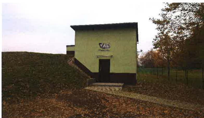
Opravený VDJ Přibyslav
